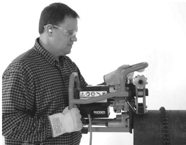
Rys. 8A – Ustawienie ukosowarki na rurze
