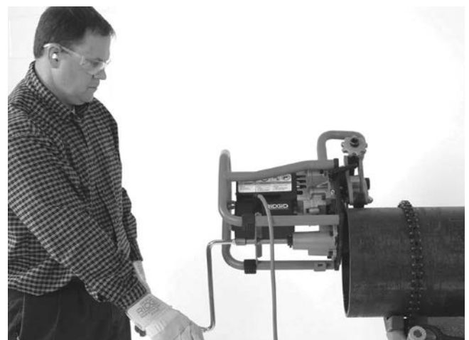
Εικόνα 15A – Εργασία φρεζαρίσματος
